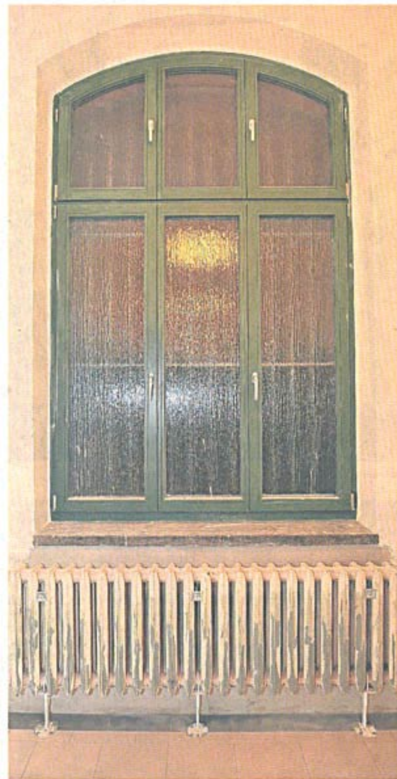
Neue Fenster in historischer Dreiteilung: Die Schule in der Mauerstraße wird derzeit energetisch saniert.
